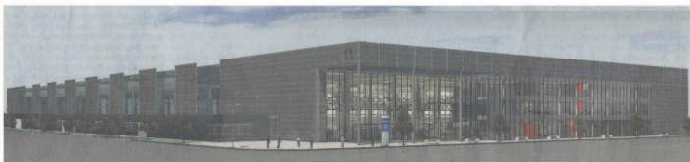
Beim Neubau schon an eine Umwidmung gedacht. Die Fassade gibt die Umrisse einer Druckmaschine wieder, während im Inneren eine einheitliche Bodenplatte und die für eine Bekranung von oben ausgelegte Materialversorgung variable Nutzungsmöglichkeiten zulassen. Der Bau der Halle, am 15. Mai begonnen, soll bis Juni 2007 abgeschlossen sein. Der Produktionsstart ist für September 2007 geplant – rechtzeitig zum 50-jährigen Jubiläum des Standortes Wiesloch.
