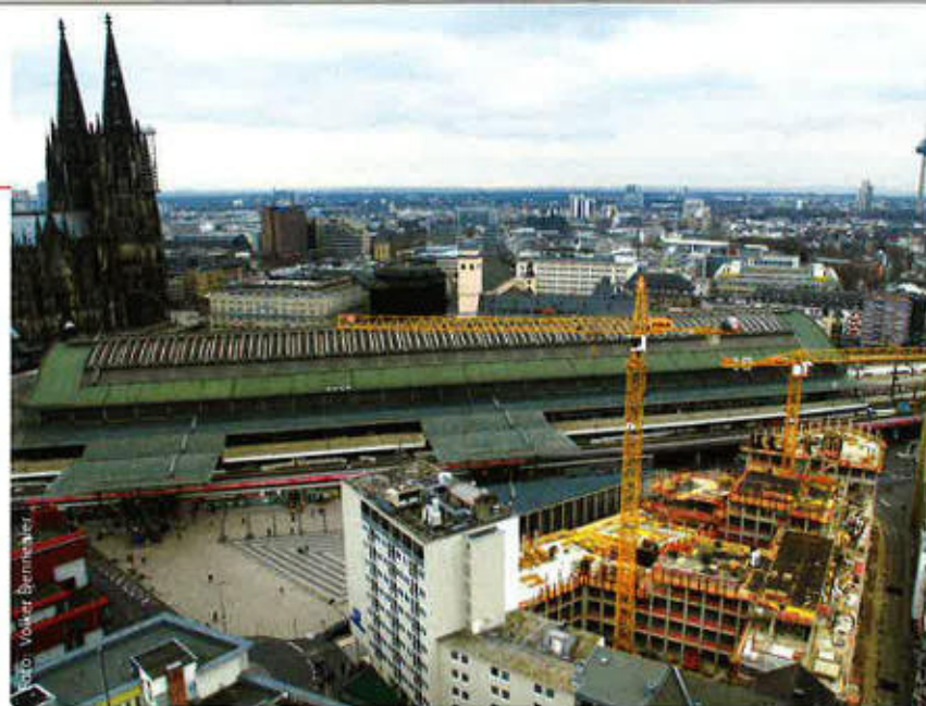
Aus Sicht einer Drohne: Züblin realisiert derzeit das Cocur Cologne in der Kölner Innenstadt.
