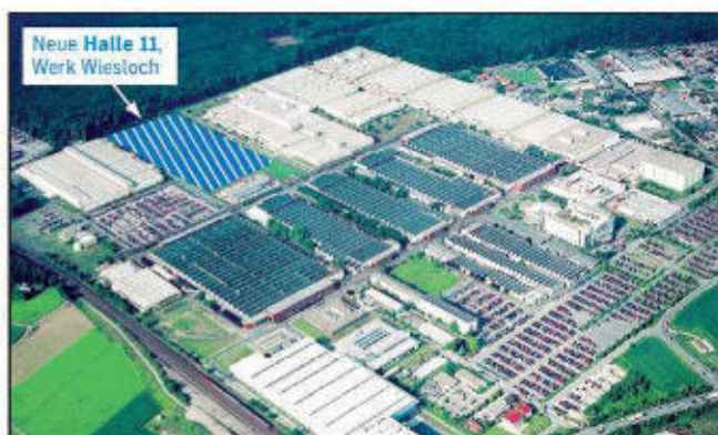
Hier entsteht die neue Halle 11 der Heidelberger Druckmaschinen AG. In der mit 35.000 Quadratmetern geplanten großen Halle wird eine neue, großformatige Druckmaschinengeneration montiert. Foto: Heidelberger Druckmaschinen AG
