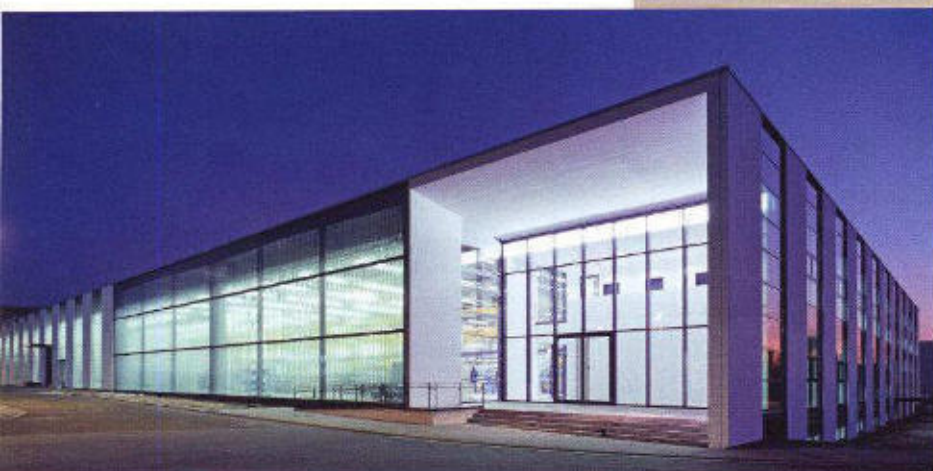
Bei Nacht erstrahlt das Gebäude durch die Innenbeleuchtung in hellem Kunstlicht
