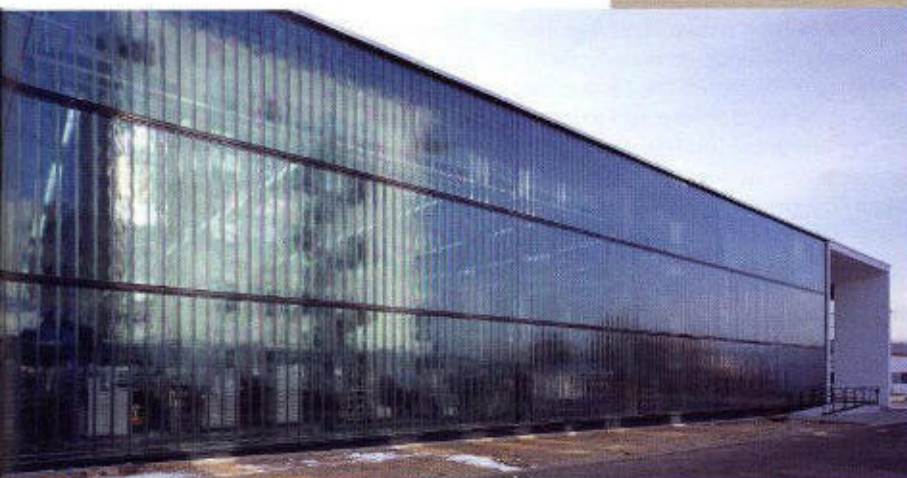
Die Glasfassade ermöglicht einen Einblick ins Halleninnere
