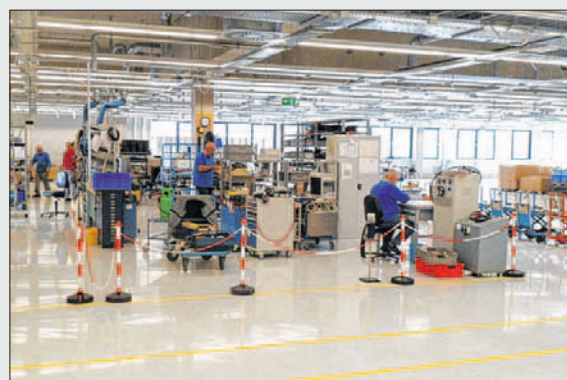
Im September 2013 konnte die neue Produktionshalle nach rund elf Monaten Bauzeit von der ersten Abteilung genutzt werden.
