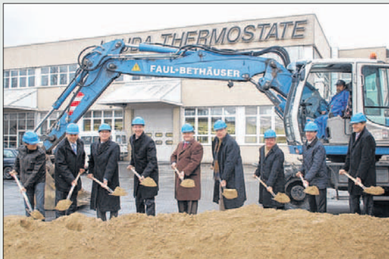
Symbolischer Auftakt der Bauarbeiten durch den Spatenstich im Dezember 2011.
