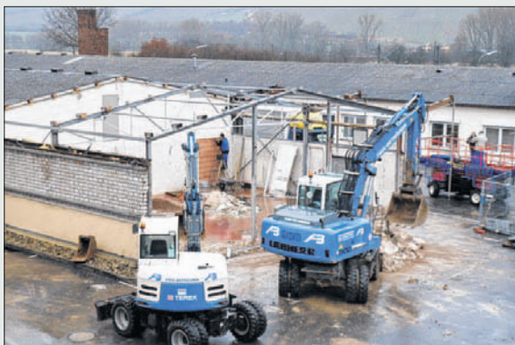
Im Januar 2012 schafft ein Teilabriss des bisherigen Versands Platz für das neue Logistikzentrum.
