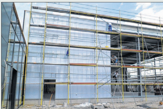
Das Logistikzentrum nimmt im März 2012 durch die Fassadenverkleidung langsam Formen an.
