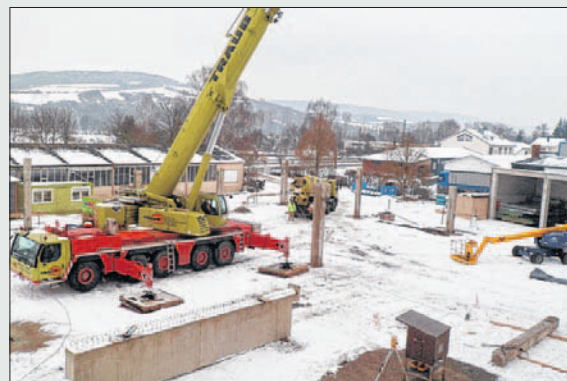
Im Oktober 2012 starten die Bauarbeiten für die neue Produktionshalle. Eis und Schnee können die Arbeiten auch über den Winter nicht stoppen.
